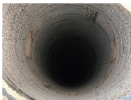
既存ライニング材撤去
