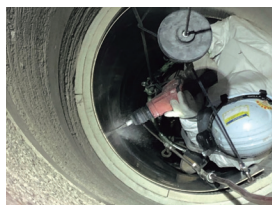
ライニング材直貼り
